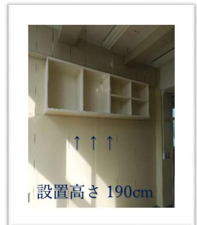
12月からは教室の仕上げ作業を行っています。流し台（混合栓2カ所）、窓側作業台、暖房機（ファンコンベクター）、190cmの高さに設置した上部棚などが設置されました。床は2層タイプのクッションシートを採用しています。
